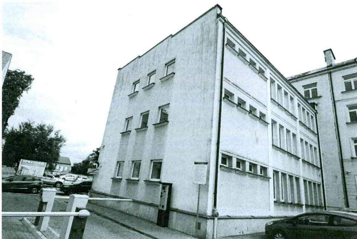
Elewacje budynku D
