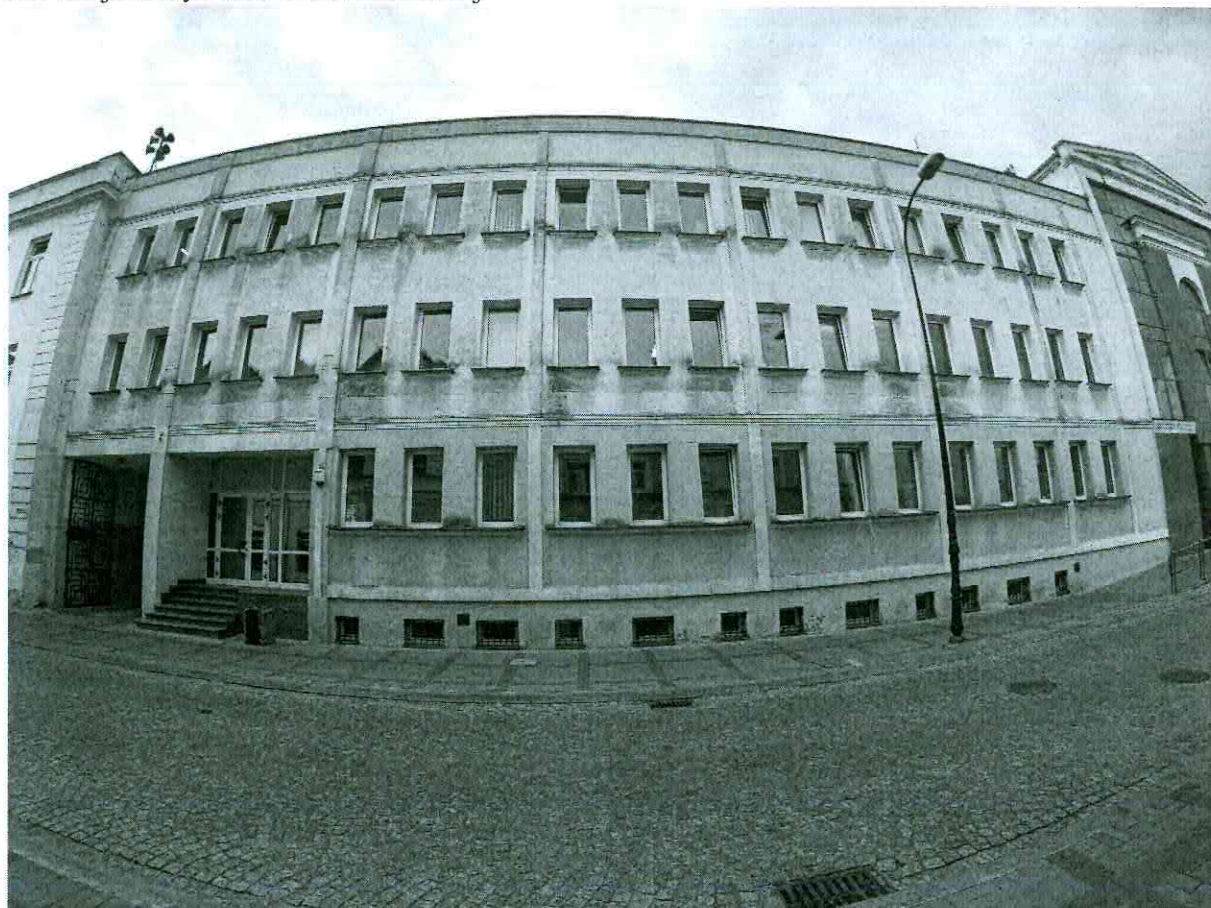
Elewacja budynku B od ul Zduńskiej
