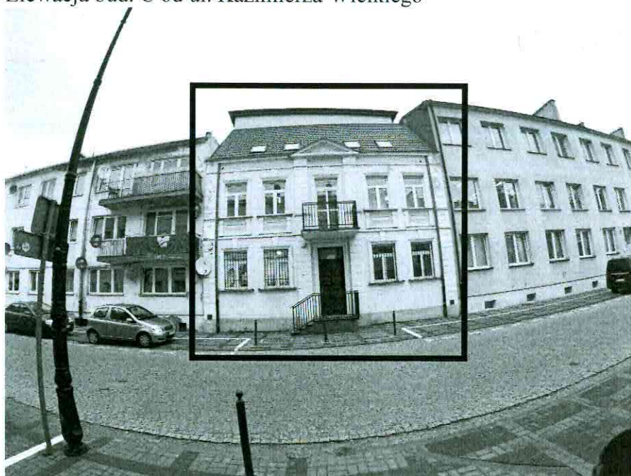
Elewacja bud. C od ul. Kazimierza Wielkiego
